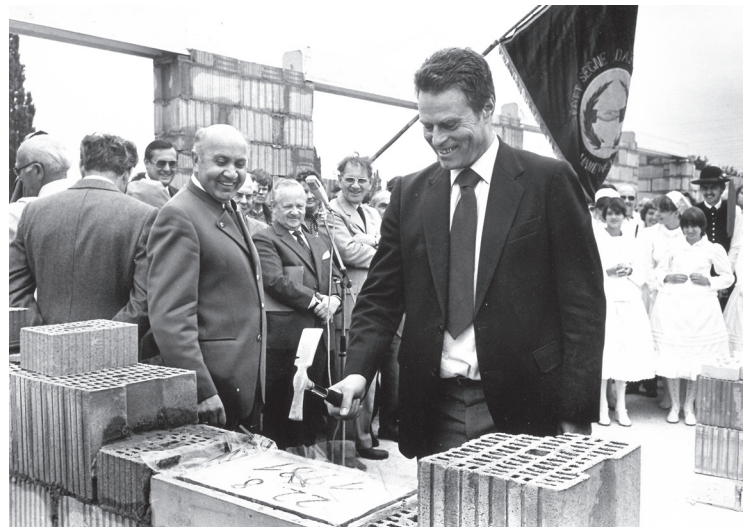
Dr. Roßkopf bei der Grundsteinlegung zum Haus Pannonia, 24.08.1981. Fotos: B Dauter
